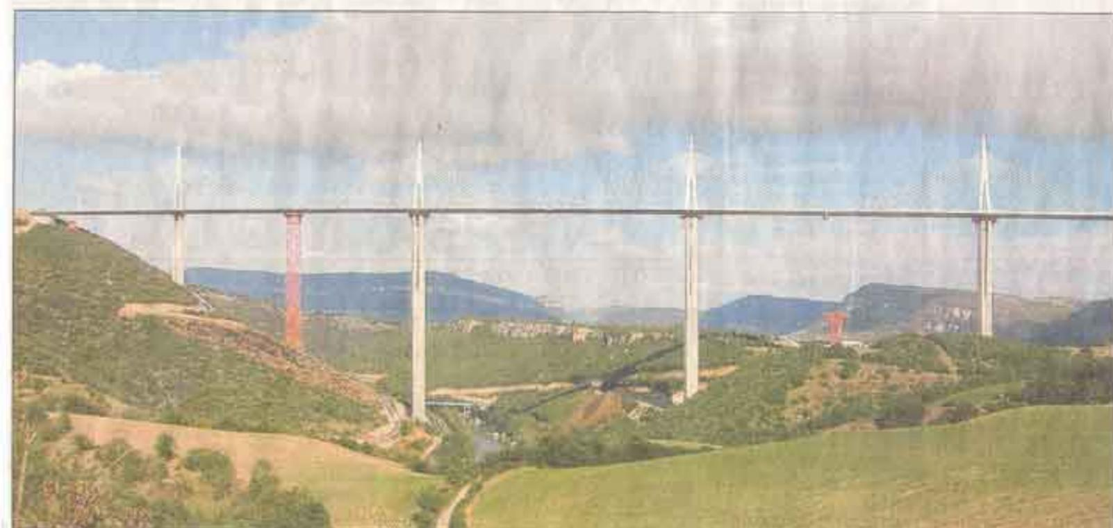
Für die Franzosen ist es schlicht das Bauwerk des Jahrhunderts: das Viaduc de Millau. Auf einer Länge von rund 2,5 Kilometer spannt sich die Brücke über das Tal des Flüsschens Tarn. Die Fahrbahn liegt 270 Meter über dem Boden. Für die Bearbeitung der Fahrbahn war vor kurzem auch eine moderne Hamm-Walze in luftiger Höhe im Einsatz.
